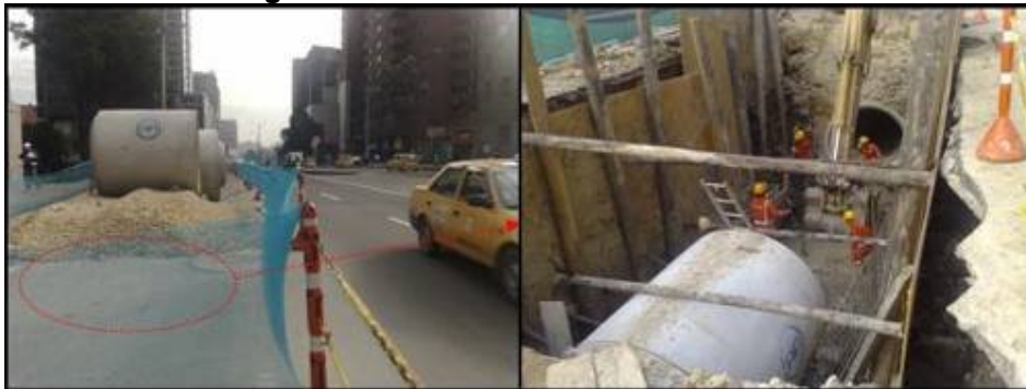
Imagen 1 Intervención alcantarillado carrera 7
