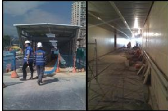
Imagen 11 Túnel peatonal – conexión estación Las Aguas con la estación Calle 22
