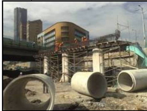
Imagen 3 Demolición puente vehicular calle 26 con avenida caracas
