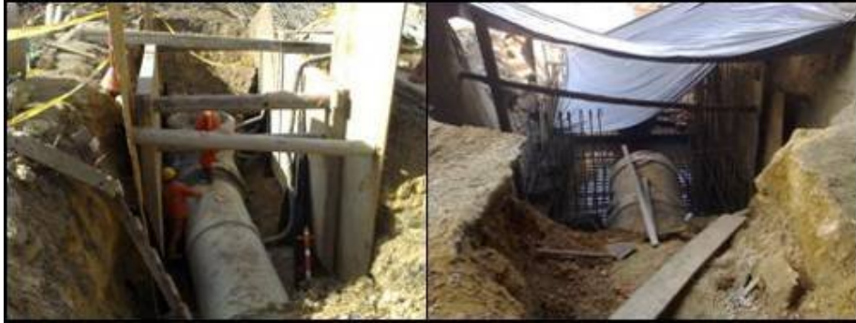
Imagen 5 Instalación de tubería de alcantarillado – Cajas de Inspección prefabricadas (izquierda) y fabricadas en sitio (derecha).
