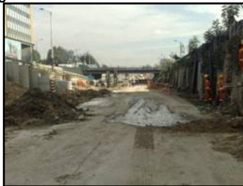
Imagen 6 Muros de contención corredor calle 26
