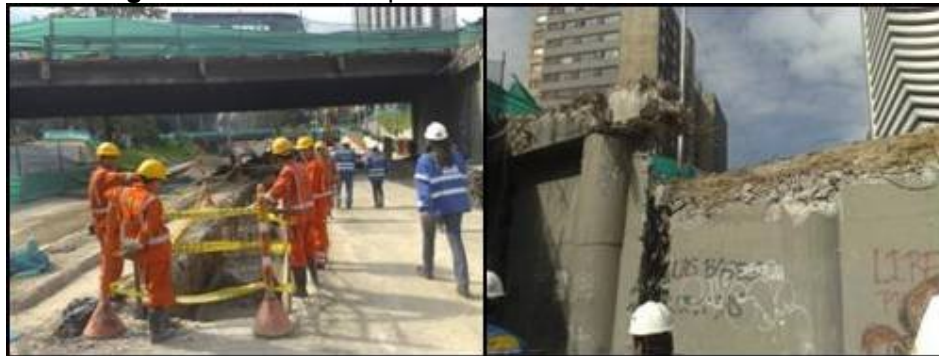
Imagen 4 Demolición de puente vehicular calle 26 con carrera 10
