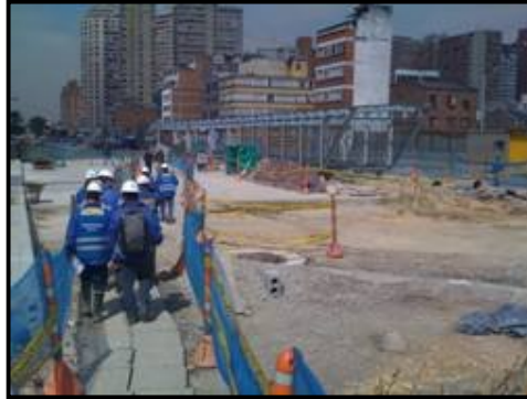
Imagen 10 Tramo carrera 3ª entre calles 19 y 26
