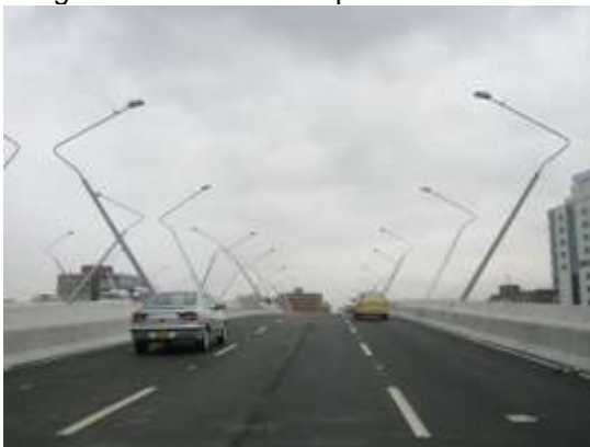
Imagen 5. Pavimento del puente vehicular
