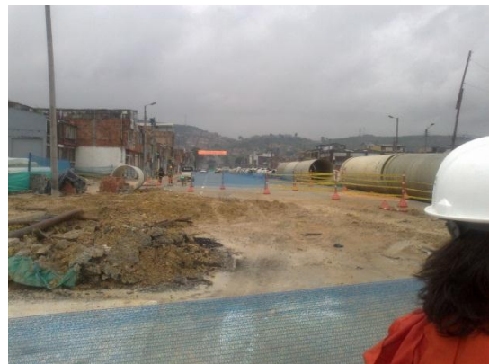
Calzada oriental Kra 10 hacia el sur de la Calle 27 sur.
