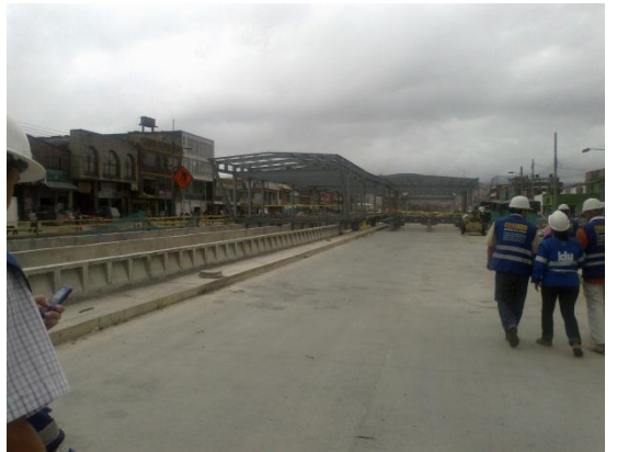
Estado del montaje de las estructuras metálicas de las estaciones de las calles Av. 1 Mayo y Calle 27 sur.
