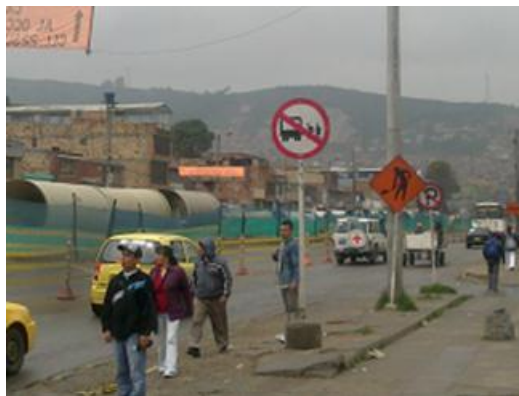
Imagen 5. Falta de avance en la Carrera 10 con Calle 27 sur. Fuente: CCB. Visita realizada el día 4/05/2011.
