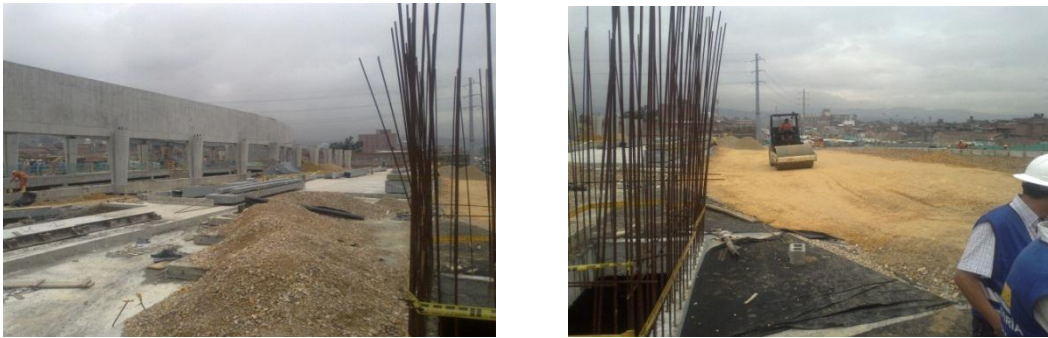
Costado occidental de la estación Av. Comuneros y vista de los accesos al anillo superior del intercambiador.
