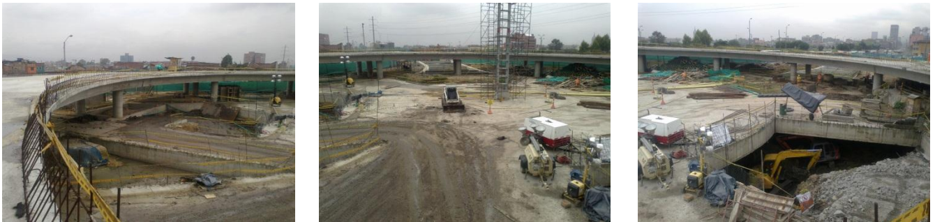
Panorámica del anillo superior del intercambiador y de la plazoleta peatonal del nivel central
