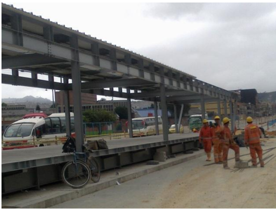
Estación Calle 11 sur.
