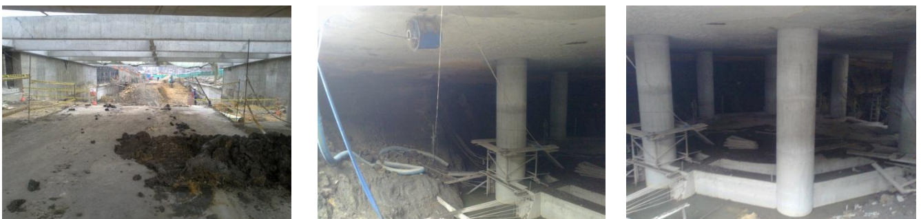
Trabajos de excavación del acceso sur del intercambiador nivel deprimido exclusivo de TM
