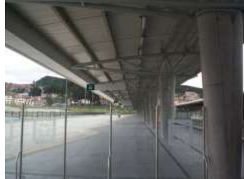
Imagen 23. Zona de cargue y descargue de pasajero de alimentadores
