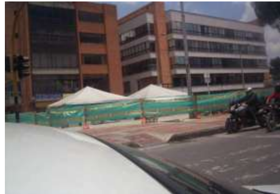
Imagen 18. Cerramiento en calle 122
