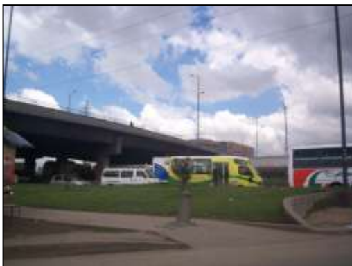
Avenida ciudad de Cali por avenida Centenario, occidente
