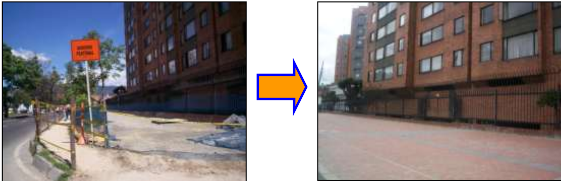
Fuente: CCB. Visita técnica
