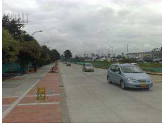
Fuente: CCB. Visita técnica de octubre 28 de 2010. Calle 26 x Carrera 80
