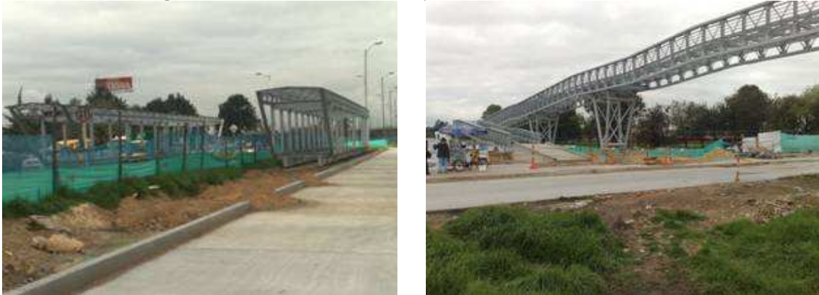
Imagen 1 Estaciones Metálicas y Puente Peatonal de Modelia
