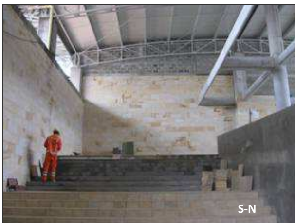
Acabados al interior del edificio
