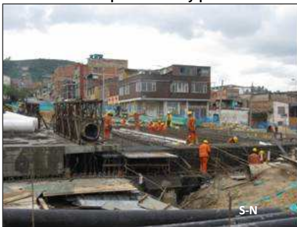
Construcción del paso a nivel para paso de vehículos particulares y peatones
