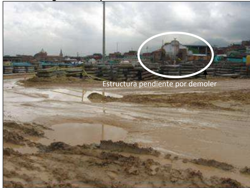
Imagen 5. Zona para el área de mantenimiento
