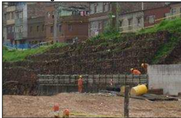
Imagen 4. Muro de contención
