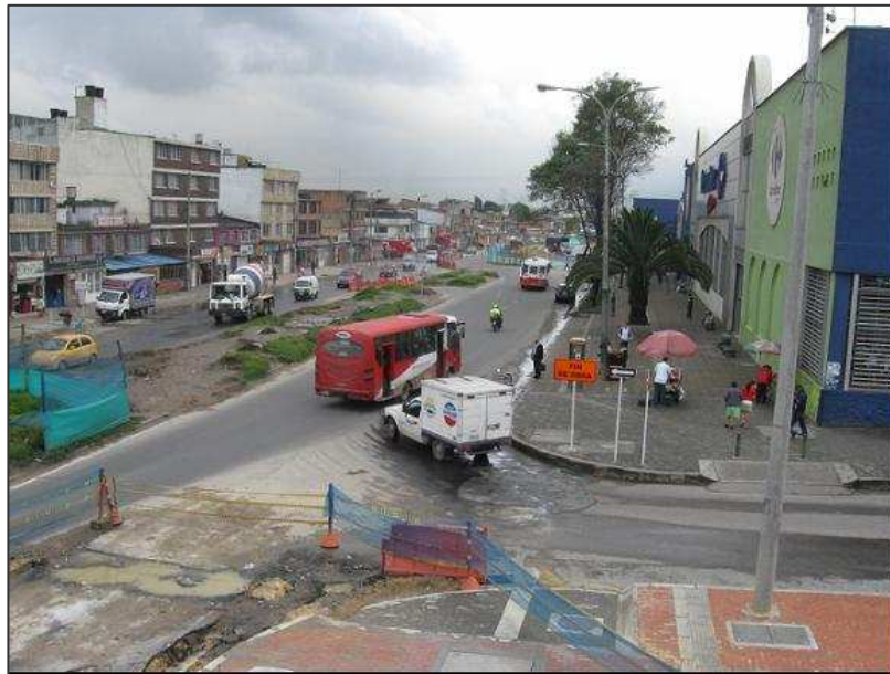
Imagen 15. Intersección Carrera 10 con Calle 31 Sur
