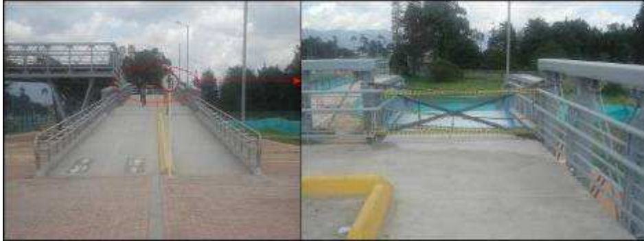
Imagen 41. Escaleras – puente carrera 94
