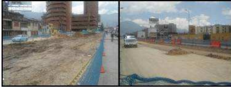
Imagen 33. Excavaciones y escarificación de pavimento
