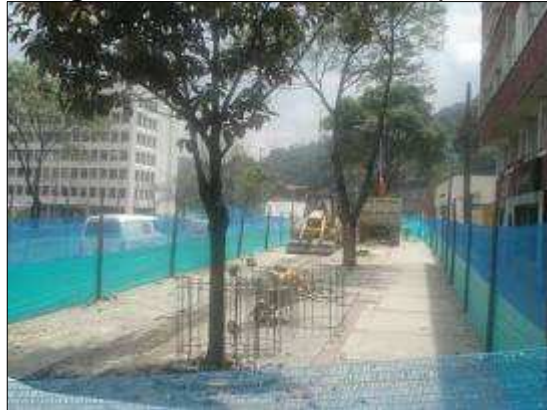
Imagen 21. Escarificación de pavimento
