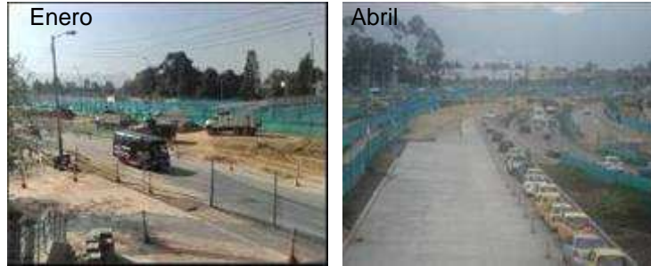
Imagen 45. Avance sector avenida Ciudad de Cali con calle 26
