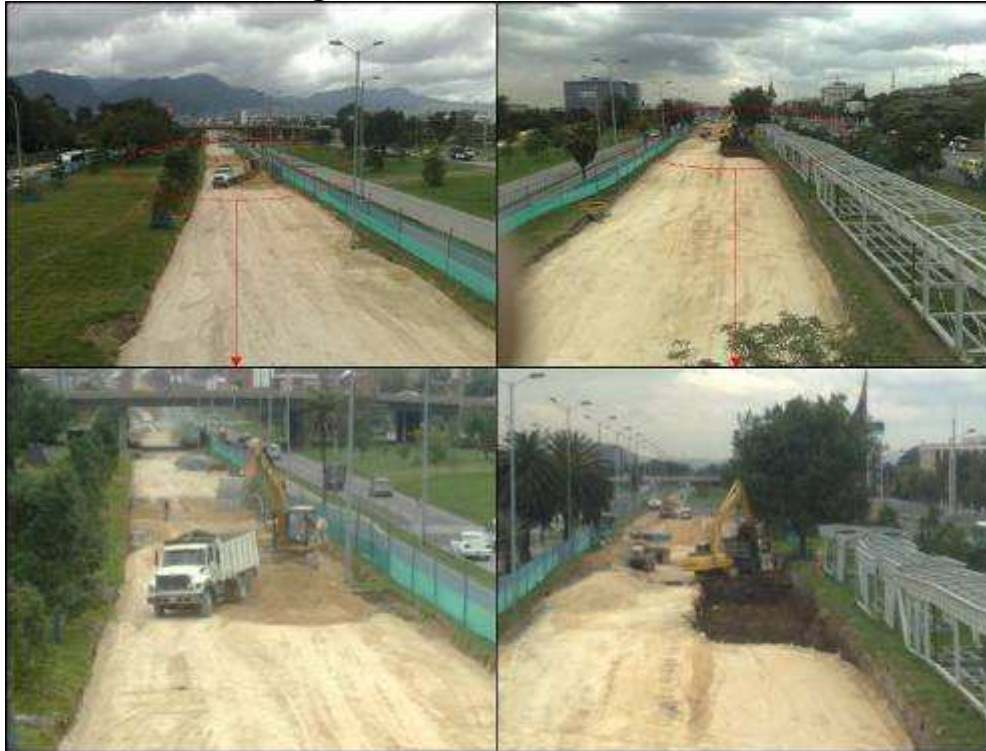
Imagen 21. Frente de obra - CAN
