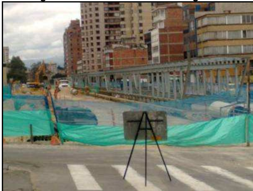
Imagen 14. Colocación de subbase granular.
