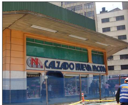
Edif. Calzado Nueva Moda
