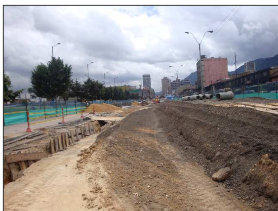
Carrera 10 Calle 7 (inicio de obra)
