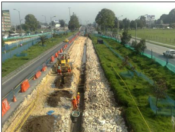
Imagen 5. Avance de obra Grupo 4 – Av. Boyacá
