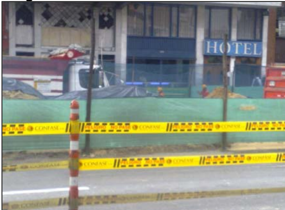
Imagen 11. Avance de obra – Carrera 10
