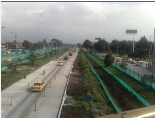
Imagen 2. Obras al Oriente de la Av. Ciudad de Cali
