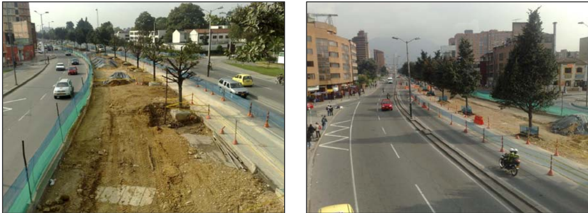
Imagen 6. Avance de obra Grupo 4 – Universidad Nacional
