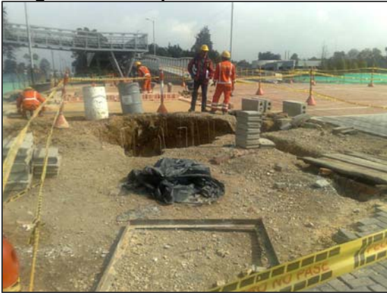
Imagen 1. Puente peatonal carrera 94
