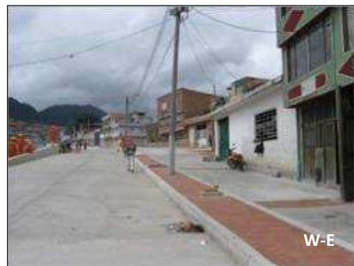
Fuente: CCB. Visita técnica del 29 de abril de 2010. Calle 31 Sur X Carrera 8
