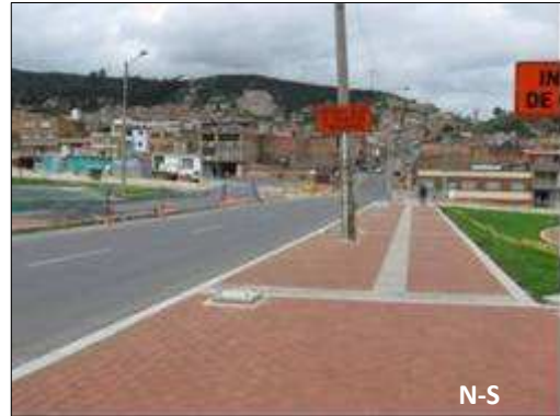
Fuente: CCB. Visita técnica del 29 de abril de 2010. Carrera 9 x 31Sur.
