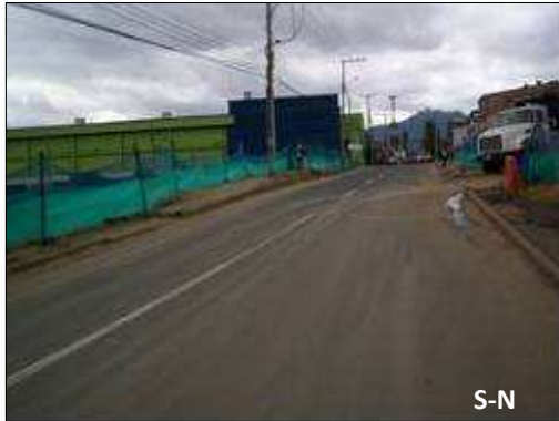
Fuente: CCB. Visita técnica del 17 de abril de 2009. Carrera 9 x 31Sur.
