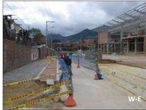
Fuente: CCB. Visita técnica del 29 de abril de 2010. Calle 30 Sur X Carrera 5
